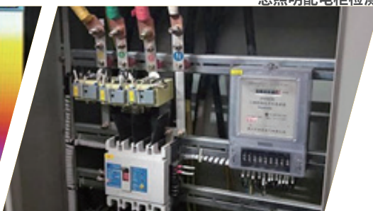
总照明配电柜检测
